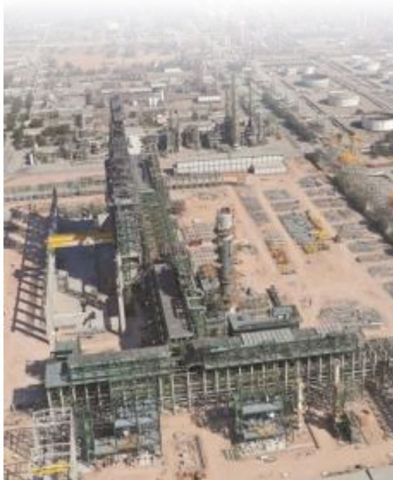
Refinería Dos Bocas
